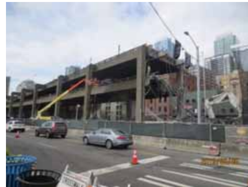
急速な取り壊し作業 HPで毎日工事報告
