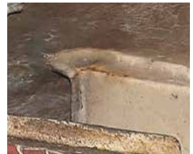
● 溶接部の塗膜割れ
