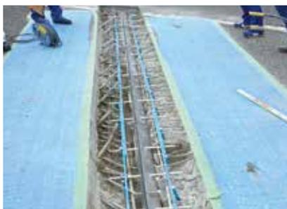
④超速硬コンクリートの打設
